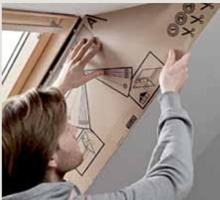
1. По шаблону, который прилагается к откосам, определяем угол наклона кровли и правильность положения верхнего и нижнего откосов. Глубина откосов LSC – 40 см.
