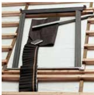
Комплект для гидро- и теплоизоляции BDX состоит из теплоизоляционного контура, гидроизоляционного фартука и дренажного желоба.
