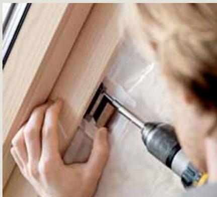
2. После утепления откосов производится герметизация пароизоляционной пленкой (BBX), которая входит в комплект. Крепится специальным скотчем (входит в комплект) к пароизоляции кровли.
