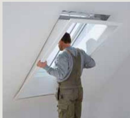
3. В собранном виде откосы легко защелкиваются на заранее установленные кронштейны. При необходимости их легко снять, не разбирая.
